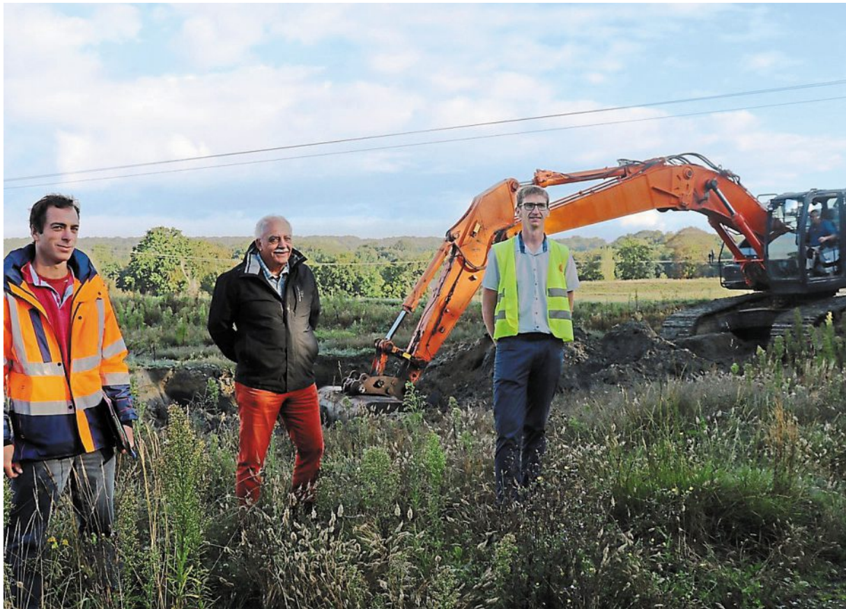
Ronan Baudet, responsable des travaux de dragage, Yves Chesnais, président de l'EPTB, et Anthony Leroyer, de l'entreprise Routière Perez, devant une pelleuse qui récupère de la vase.
